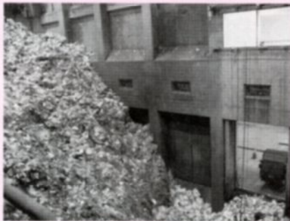
1月末日現在のごみピットの様子
